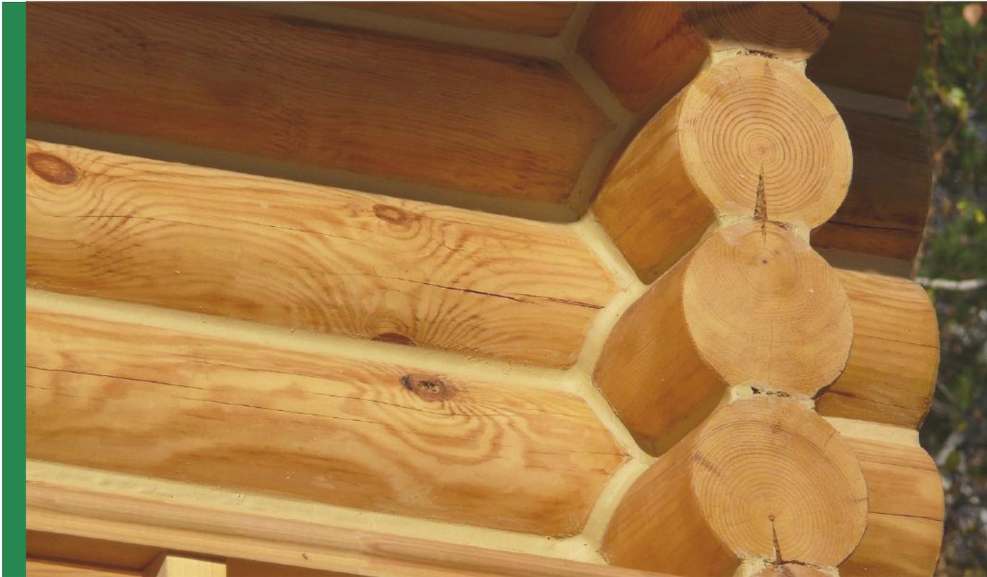
Основными каналами утечки тепла из деревянного строения являются щели между венцами, которые и необходимо заделать. Для этого и используется межвенцовый утеплитель (прокладочный теплоизоляционный материал).
